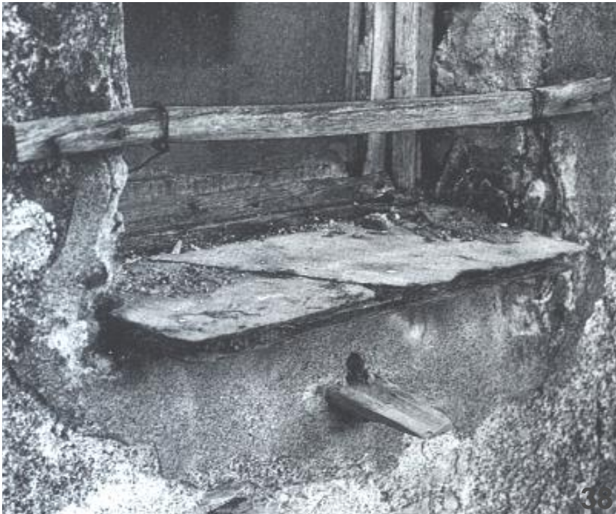
Pianale di finestra e relativo elemento in ardesia per scolo delle acque
