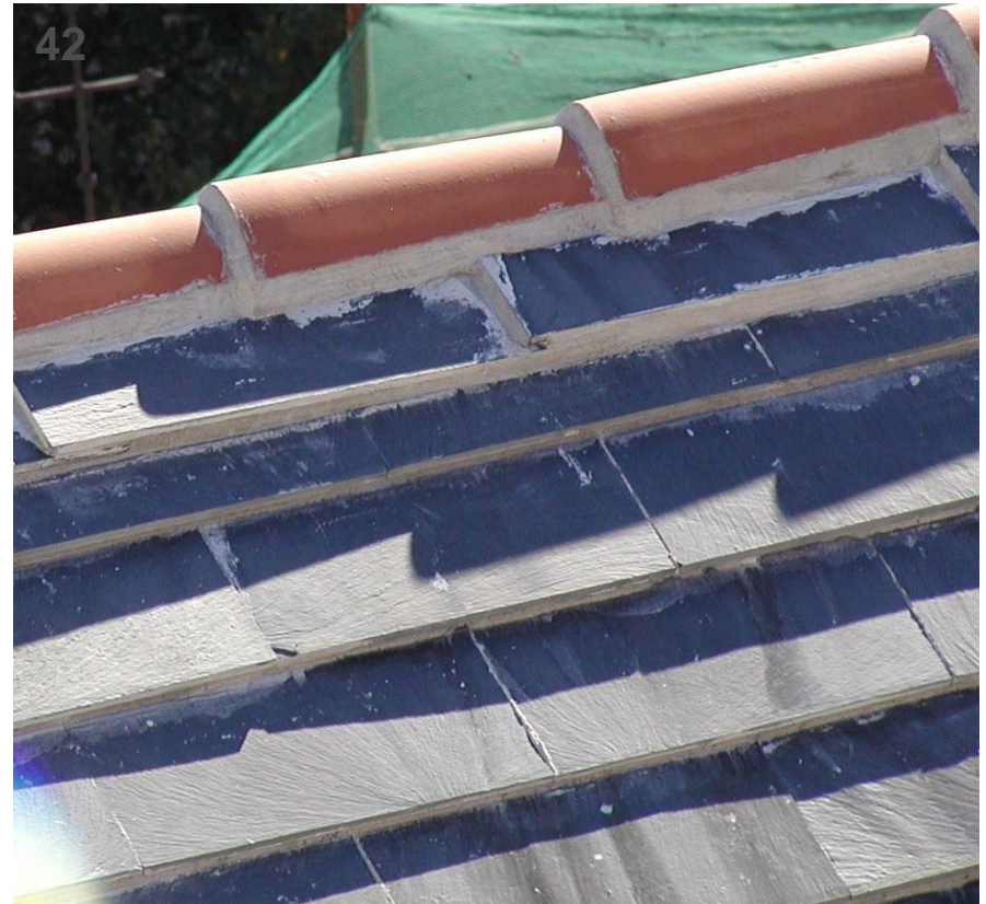
Particolare del manto del tetto del Convento del Padre Santo dei Cappuccini a Genova appena rifatto con stuccatura a malta secondo la tradizione
