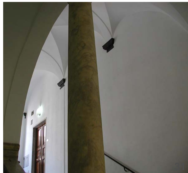
Peducci in ardesia nel vano scala voltato di un palazzo di Salita S. Matteo a Genova
