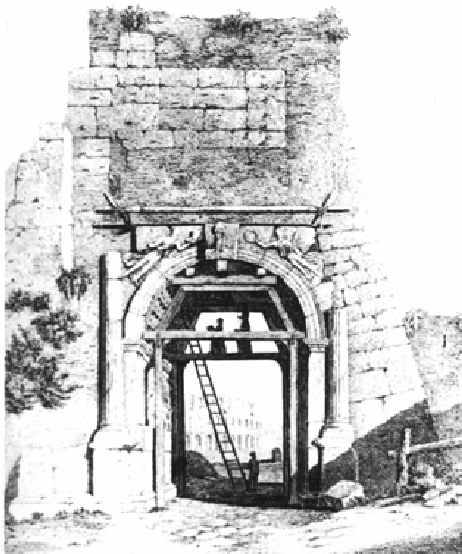
Arco di Tito in fase di smontaggio e il rilievo degli elementi originari sopravvissuti
