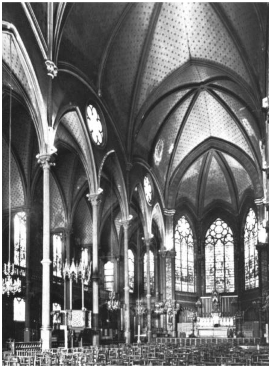
Louis-Auguste Boileau, Saint Eugène, 1854-55. Uso di colonna in ghisa in una chiesa neogotica fortemente criticato da Viollet le Duc
