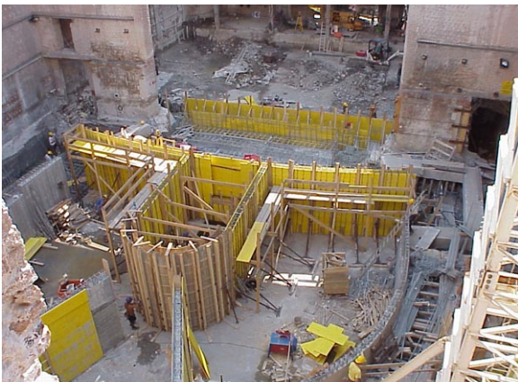
(ricostruzione fondazioni palcoscenico)
