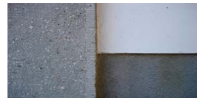
Materiali di facciata, 2006 (Danzl), a sinistra: cemento armato trattato a mo' di scalpellino, a destra sopra: intonaco su base di calce aerea, scialbato “a fresco”, conservato e restaurato, a destra sotto: intonaco “Terranova” grattato contenente mica e polvere di ardesia
