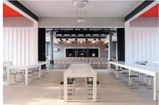
Mensa, 2005 (Bettina Litz, Stiftung Bauhaus Dessau), il pavimento Xyolith è stato conservato e restaurato, la polichromia ricostruita in materiale e tecnica a secondo gli analisi.
