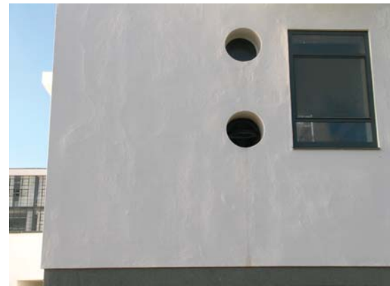
Facciata "Est", dettaglio a luce radente della superficie conservata e restaurata, 2006 (Danzl)
