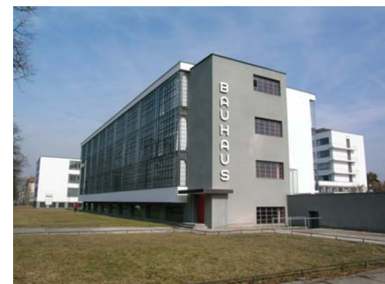
Facciata Sud-Ovest „Werkstattgebäude“ 2006 (Danzl) con il „curtain wall“ ricostruito nel 1976 e conservata nel restauro del 2004, e
