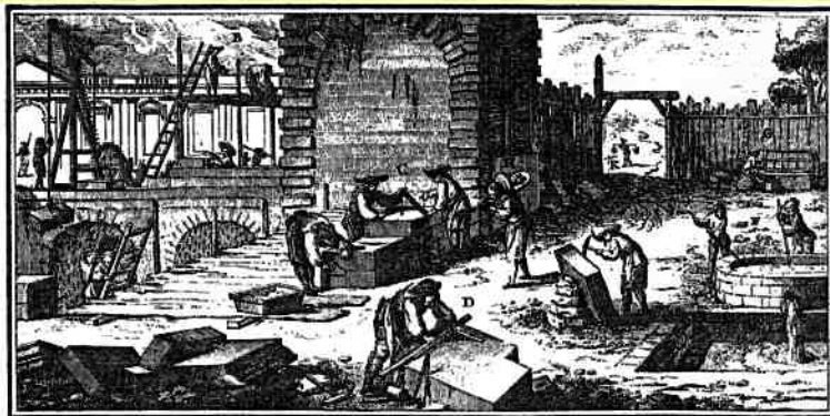
Un cantiere del XVIII secolo, dall'Encyclopédie di Diderot e d'Alembert
