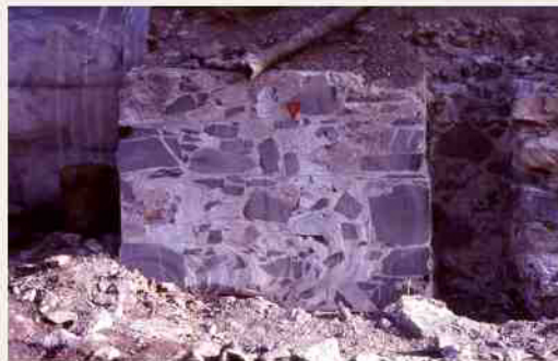
Muratura di un ponte medioevale del porto di Genova
